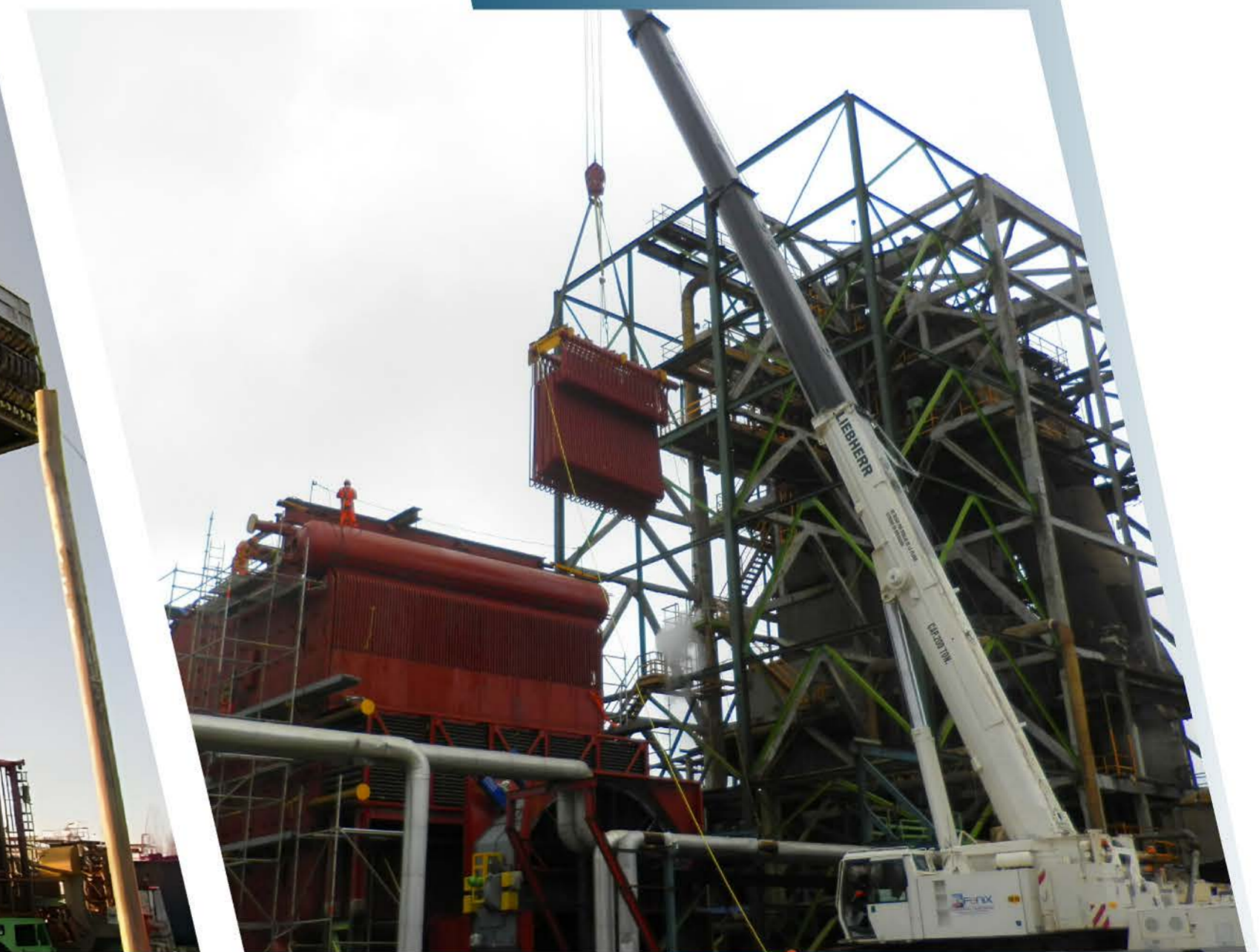
Cambio de caldera
