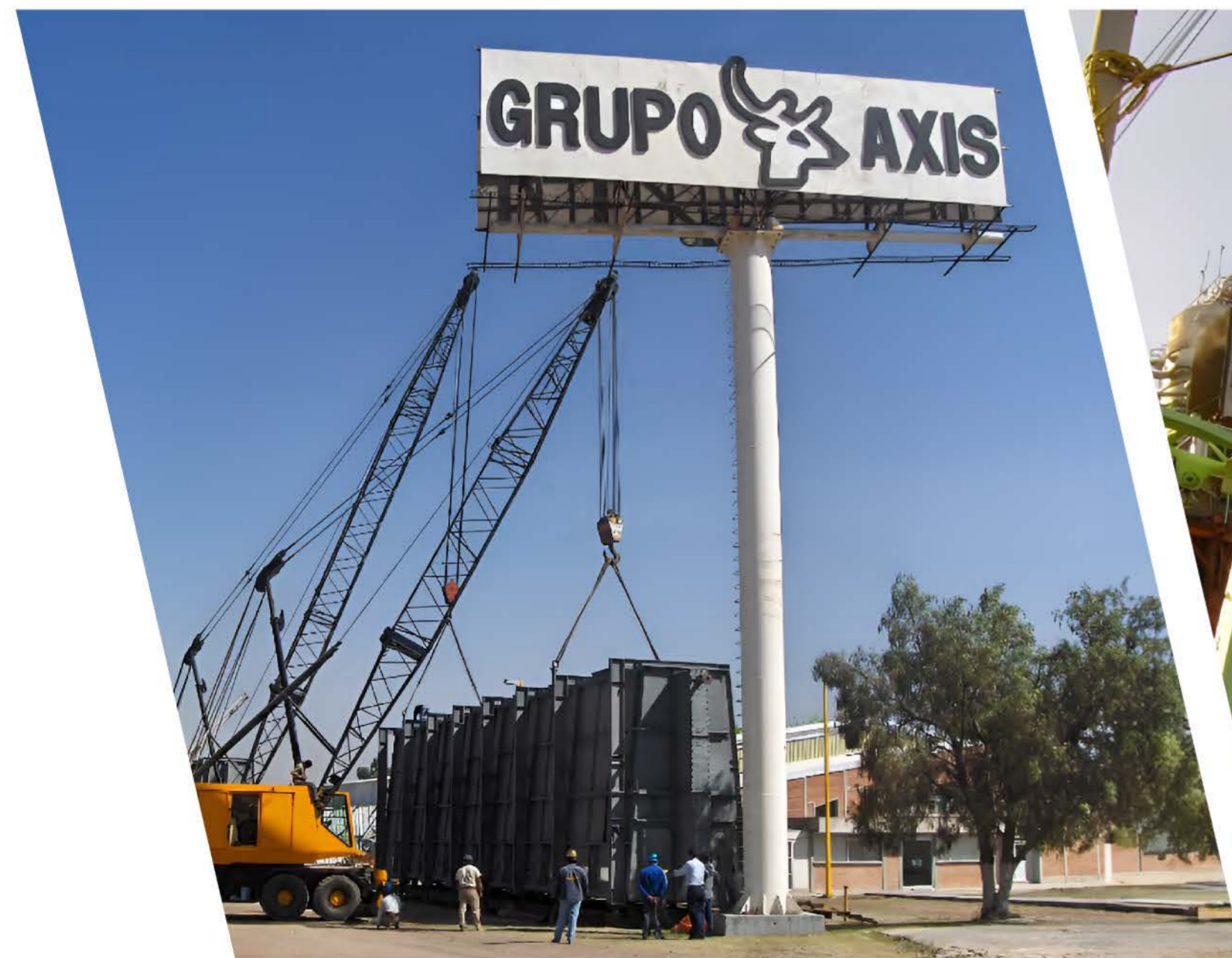
Sección de Convección de Coquizador
