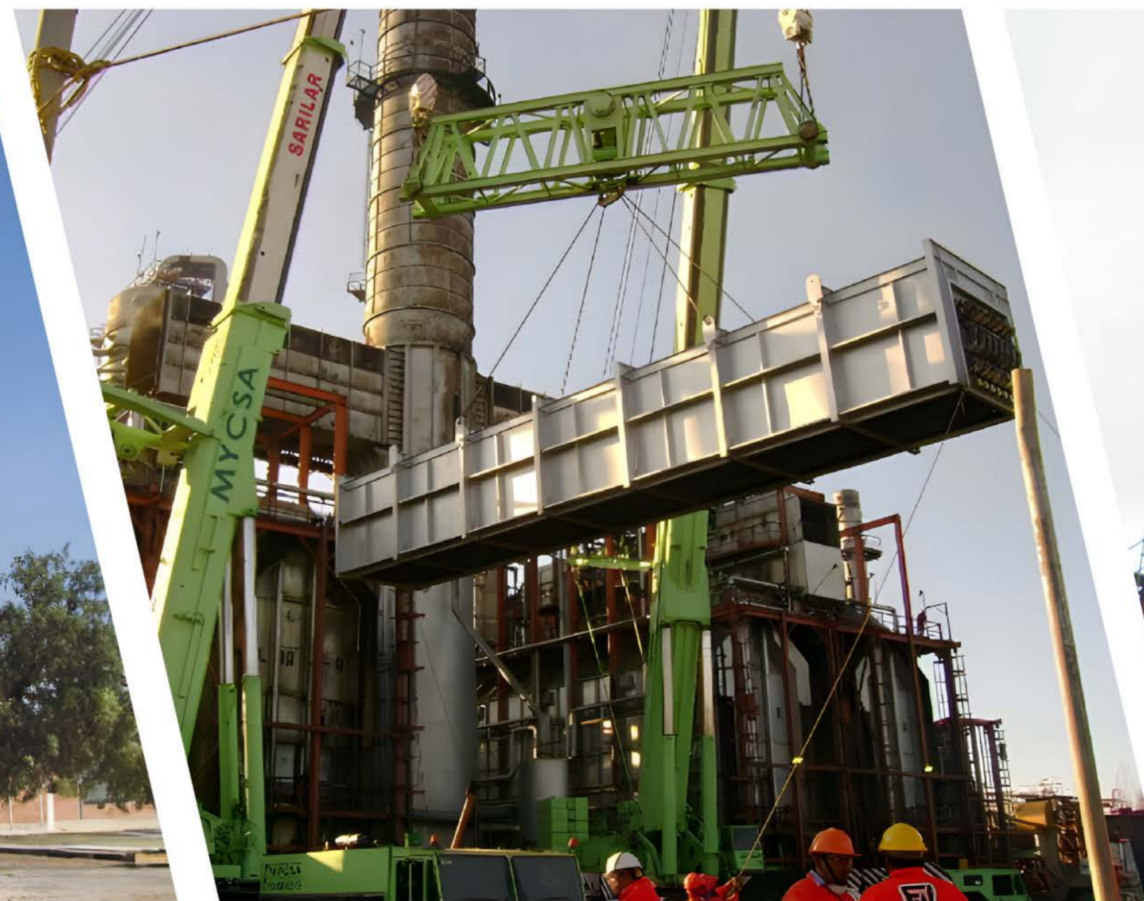
Rehabilitación de ABA
