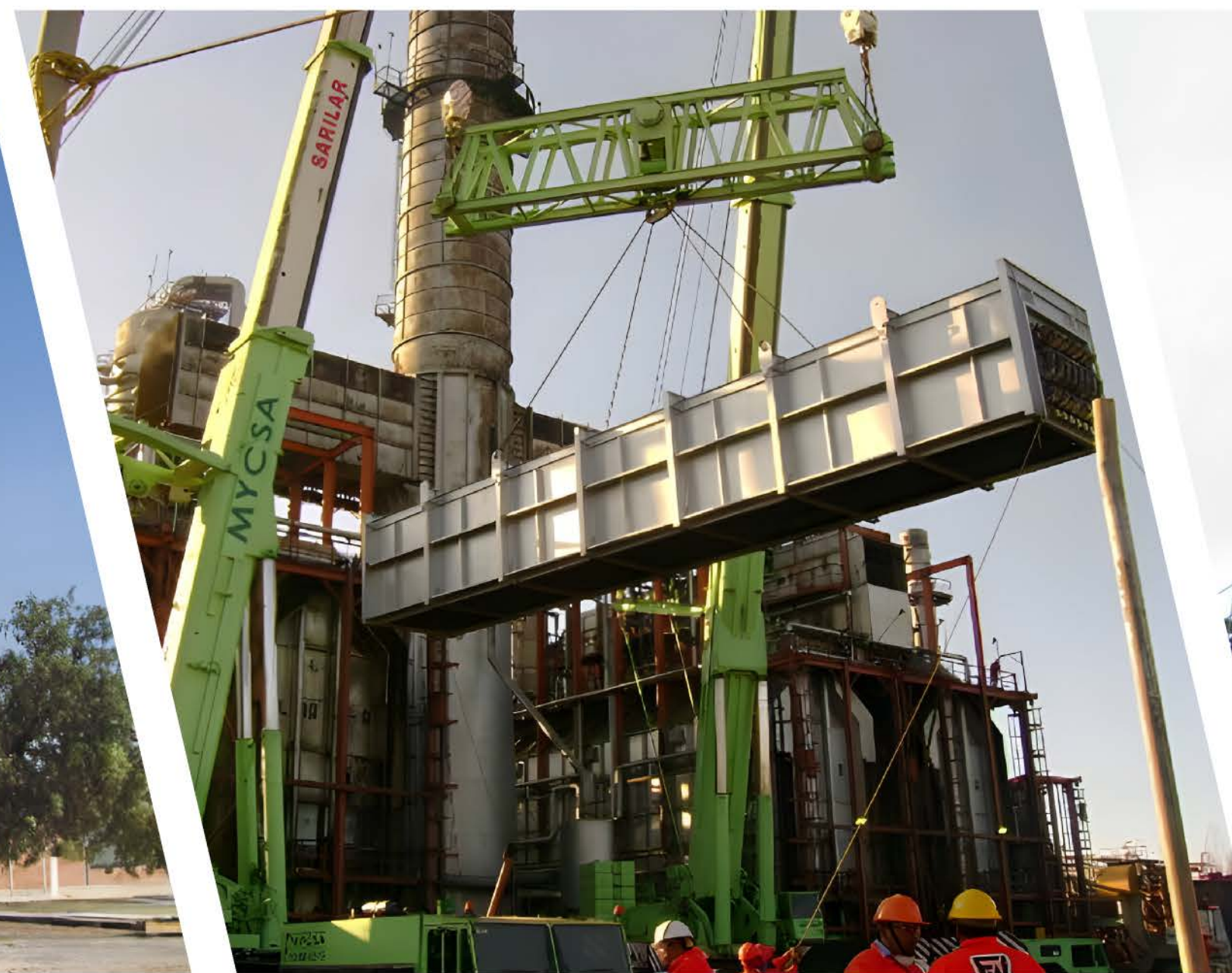
Rehabilitación de ABA
