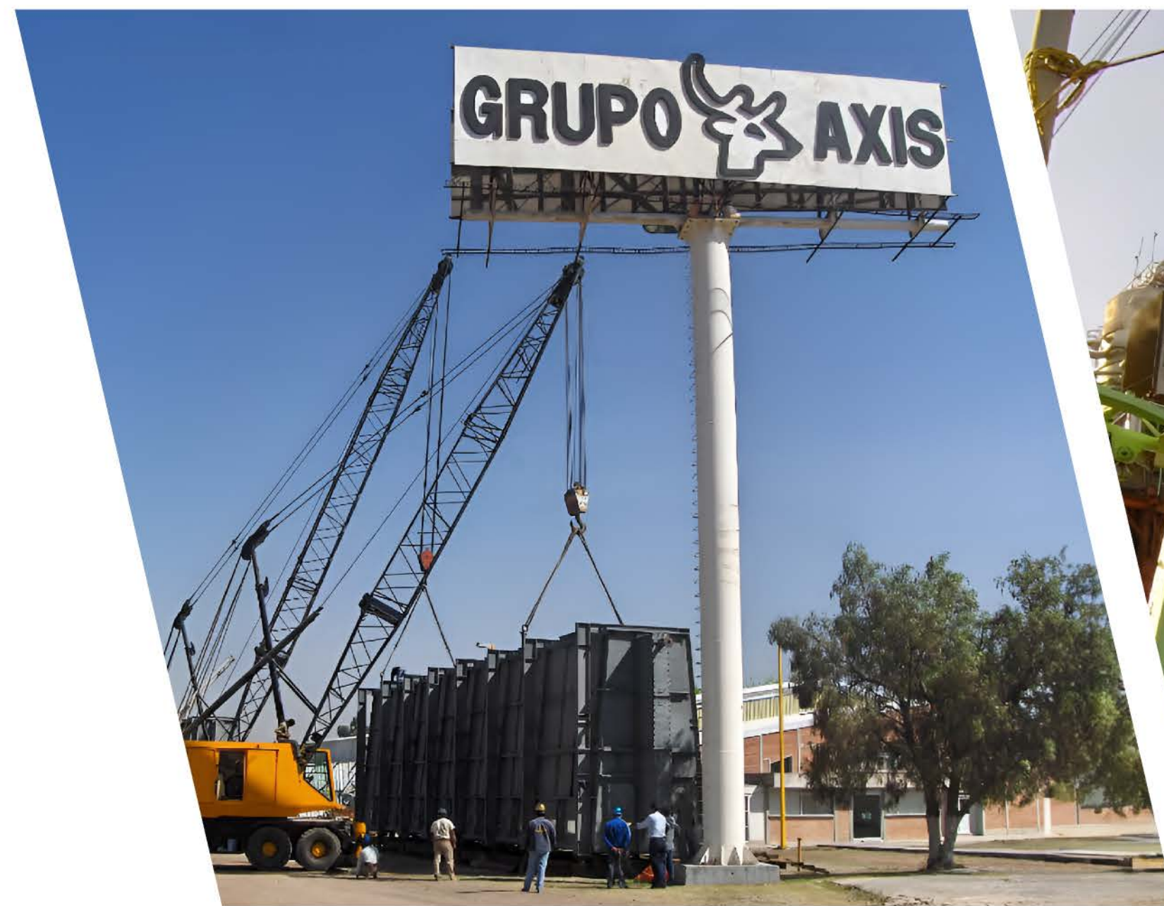
Sección de Convección de Coquizador
