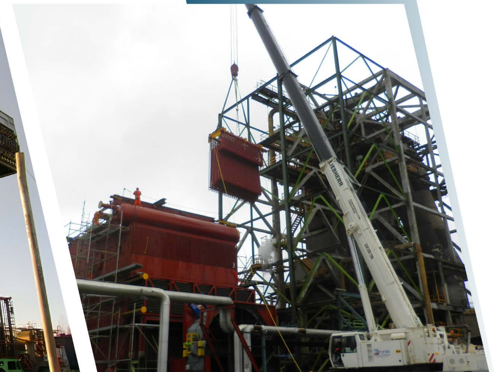
Cambio de caldera
